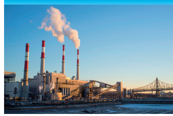
工場(汚水・汚泥)
